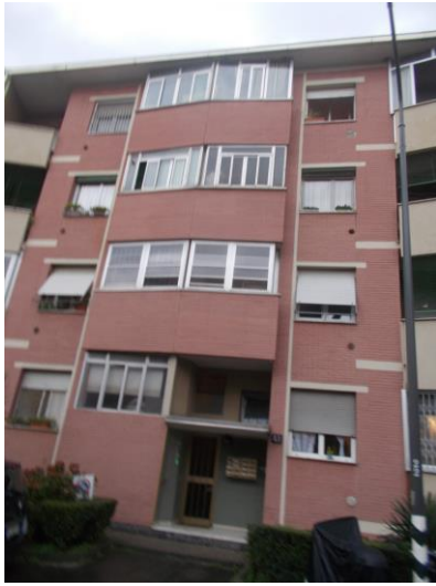
1. Facciata esterna dell'intera palazzina
