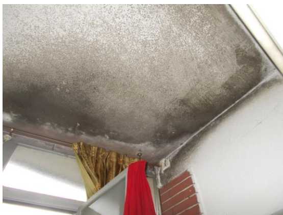
29. Soffitto del balcone
