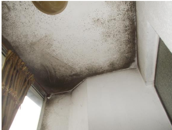
19. Soffitto del bagno
