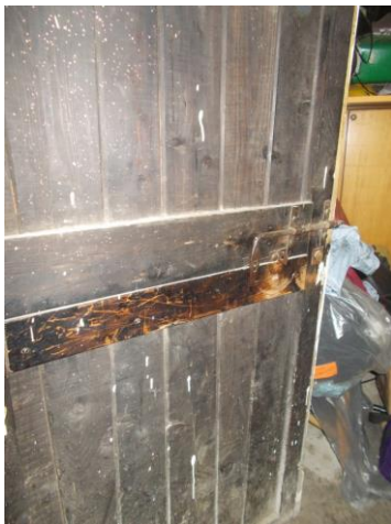
57. Porta della cantina
