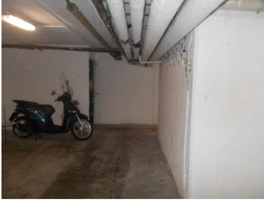
55. Area comune alle cantine
