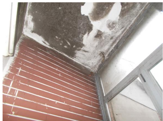
30. Soffitto del balcone
