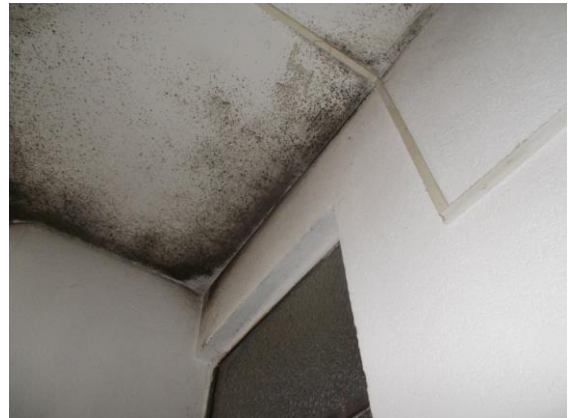
20. Soffitto del bagno
