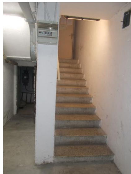
54. Scala di accesso alle cantine
